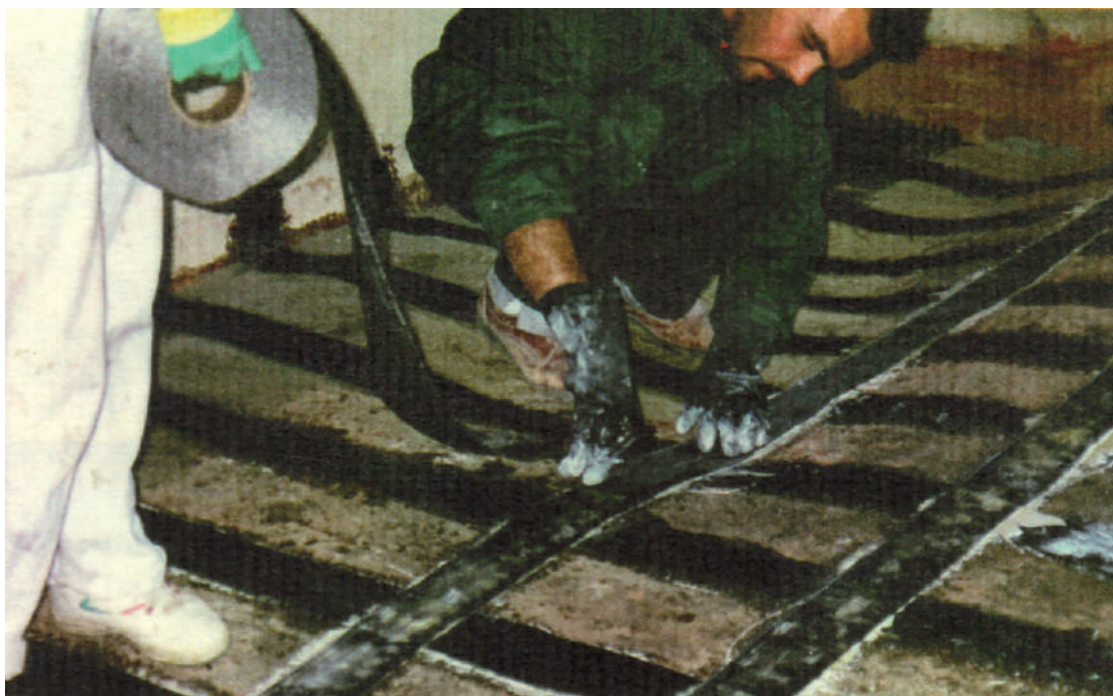
(Alcune fasi di applicazione del rinforzo in carbonio)
