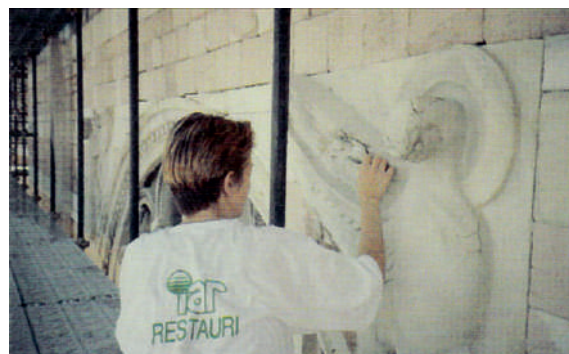
(Alcune fasi relative agli interventi di conservazione)
