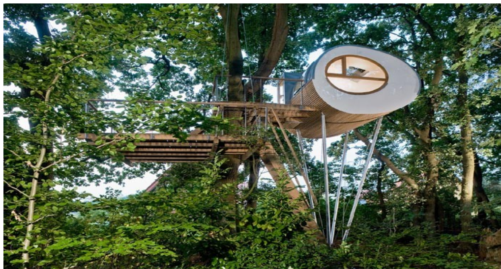
Figura 18: Realizzazione Studio Baumraum (Germania)
