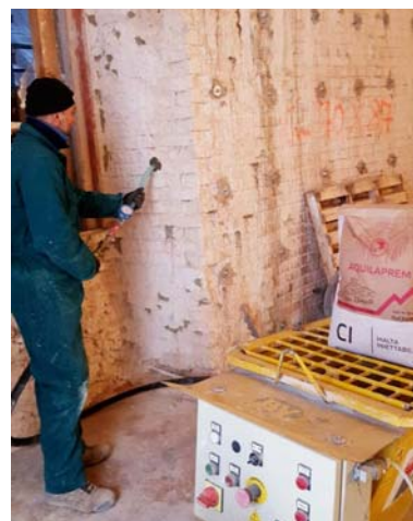
INIEZIONI DI CALCE IDRAULICA NATURALE NHL
