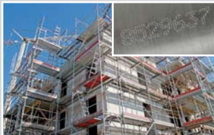
Montaggio di impalcature
