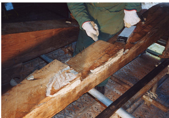
Stuccatura delle fessure da ritiro, da notare le teste dei chiodi di rinforzo già infissi
