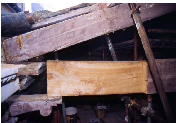
A taglio eseguito si rifinisce con la pialla.
