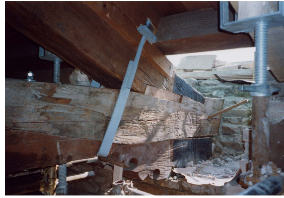
Particolare della testata, si noti la notevole estensione della chiave fra puntone e catena per saltare la zona degradata del puntone e la barra metallica in testa contro lo sfilamento della capriata dal muro in fase sismica
