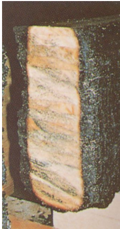
Foto 5.2: Trave di legno sottoposta ad incendio. Sotto lo strato carbonizzato il legno è ancora efficiente dal punto di vista meccanico.
