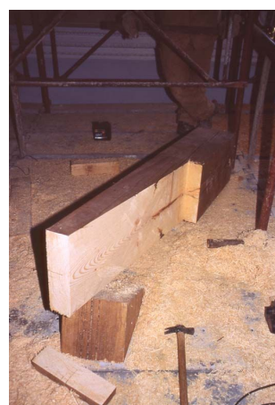
Vista della protesi durante la fase di lavorazione in cantiere.
