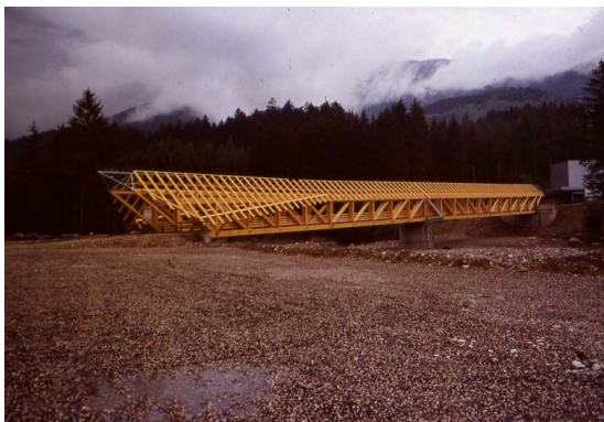
Ponte di legno lamellare incollato in costruzione; la copertura assicurerà lunga durata all'opera.
