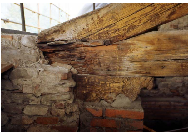
Vista della testata prima dell'intervento
