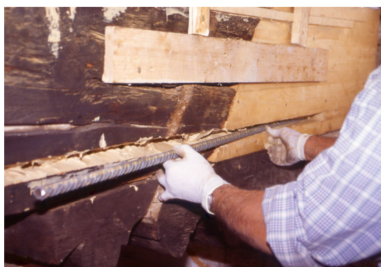
Inserimento della barra di acciaio.
