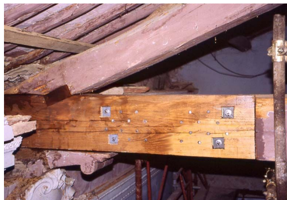
Vista dell'intervento finito, prima della colorazione, da notare l'estensione della chiave di quercia che consente di raggiungere la zona di legno sano del puntone.
