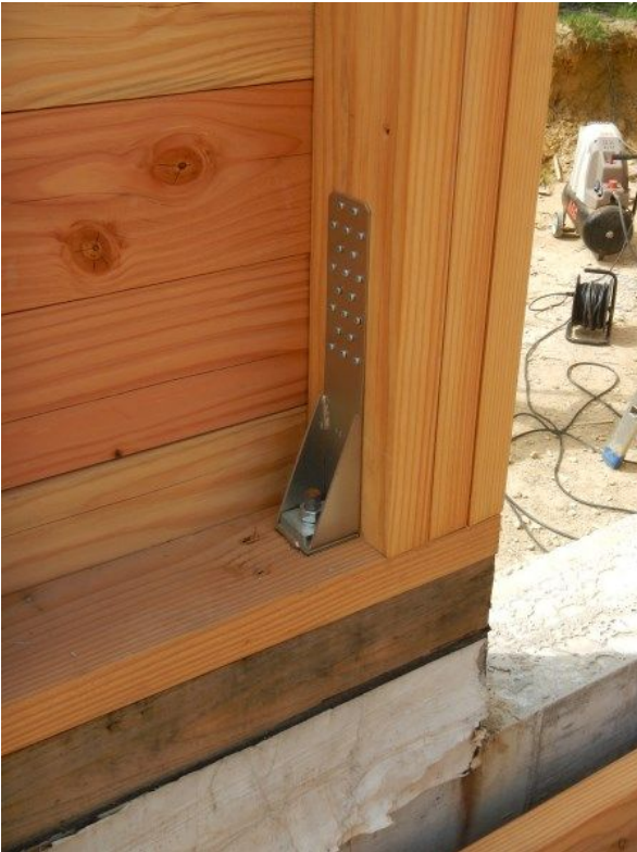
Foto 4.1: Hold-down in un edificio platform-frame.
