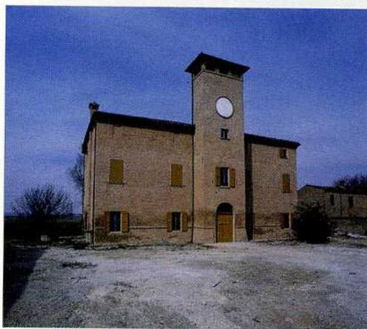
Il palazzo dei Ronchi durante il restauro.
