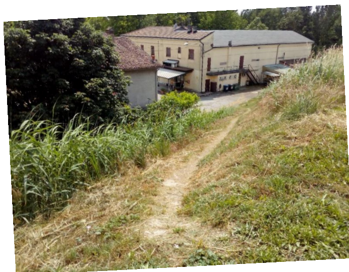
La rampa di salita/discesa dall'argine del Fiume, per arrivare alla frazione di Caselle
