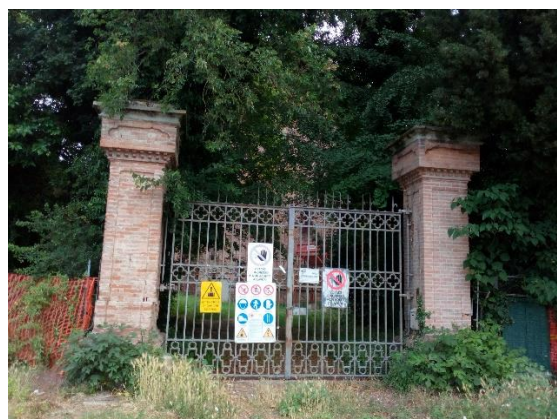
L'Ingresso al Castello
