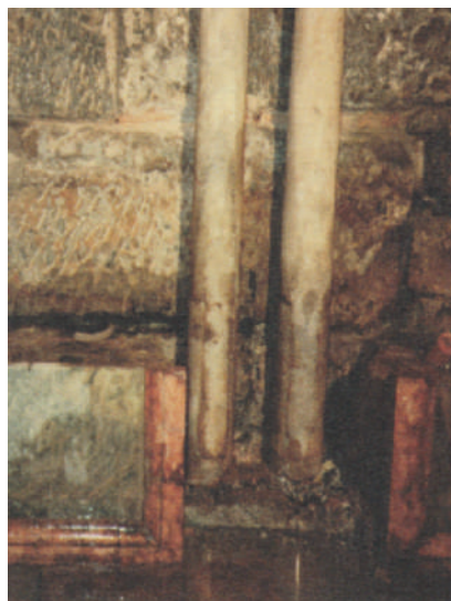
(Particolare di due colonnine in marmo e operazione di carotaggio per eseguire le iniezioni di resina in profondità)
