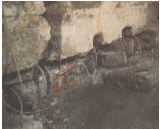
(Foto delle pareti della Cripta scattate durante le fasi di drenaggio e deumidificazione dell'acqua)
