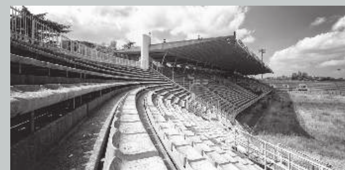
Pier Luigi Nervi, Stadio Flaminio, Roma. In alto: l'impianto sportivo in costruzione. In basso: l'attuale stato di abbandono.
