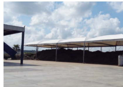
FIGURA 5. Area di stoccaggio presso l'impianto
