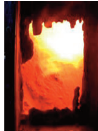
FIGURA 6. La caldaia a griglia mobile da 4,4 MWth
