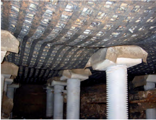
Effetto membrana della geogriglia antipunzonamento in rilevati fondati su pali (Ferrovia Bidor-Rawang, Malesia)
