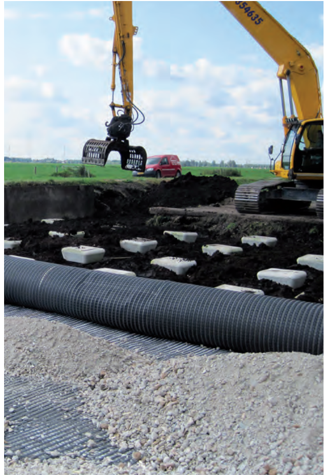
Geosintetici di rinforzo posati su pali (N210, Paesi Bassi)
