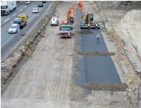
Attraversamento di cavità (Svincolo autostradale di Bochum Westkreuz [A 52], Germania)
