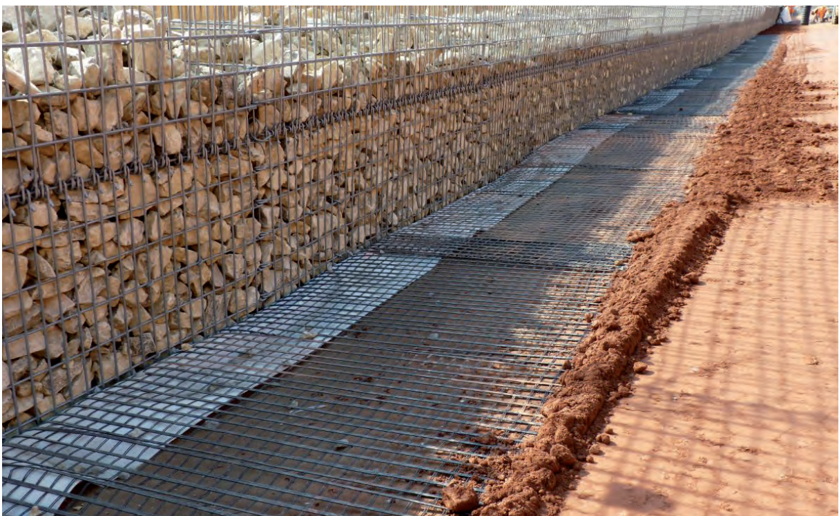
Terra rinforzata con paramento in gabbioni (Autostrada A3 nei pressi di Haseltal, Germania)
