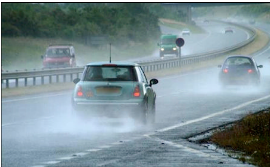
Figura 107 –Asfalto non drenante
