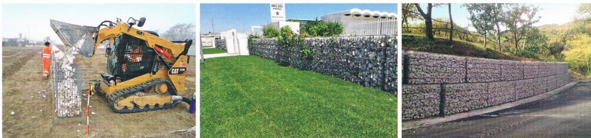
*Le gabbionate non sollevabili vengono utilizzate per la loro rapidità di riempimento principalmente in aree dove la movimentazione del materiale inerte con mezzi operatori non è ostacolata*
