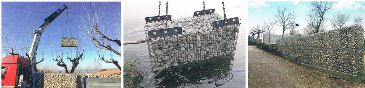
*Le gabbionate sollevabili vengono utilizzate dove si richiede rapidità e pulizia dell'intervento oppure per necessità, a causa di difficoltà di accesso con mezzi operatori al sito di cantiere, presenza di spazi angusti o in presenza di acqua*
