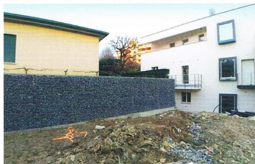
*Muro di recinzione in continuo realizzata con gabbionate*
