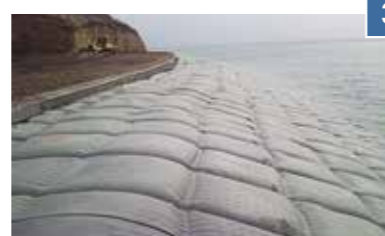
Riempimento con calcestruzzo fluido
