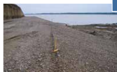
Preparazione del piano di posa
