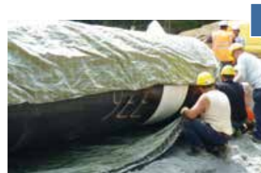
Fissaggio alla condotta
