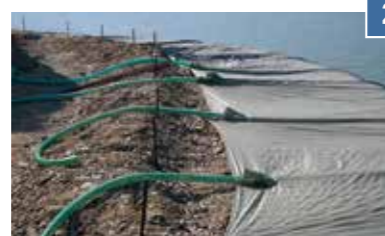
Posa dei pannelli
