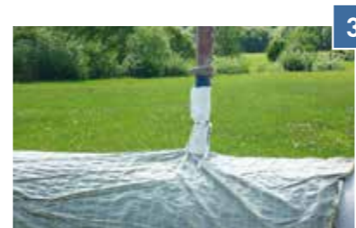
Pompaggio di calcestruzzo attraverso i bocchettoni
