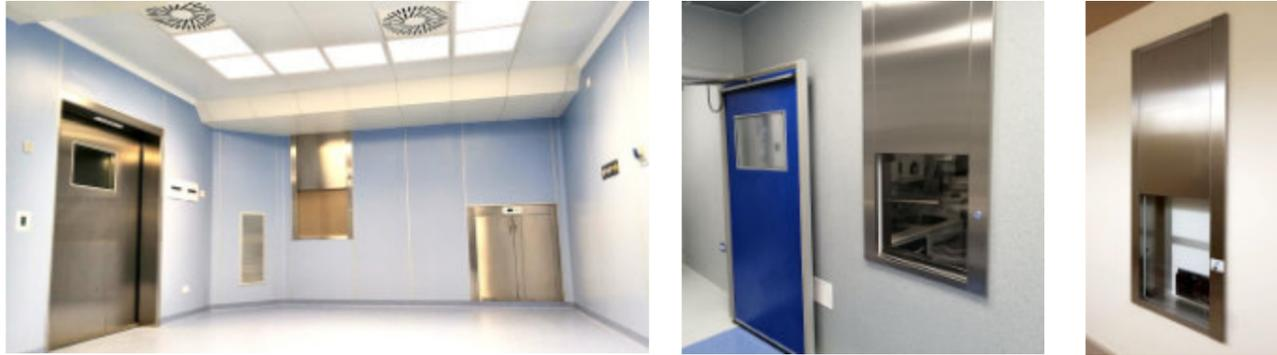
Passa sporco in versione automatica in acciaio inox con sistema di interblocco
