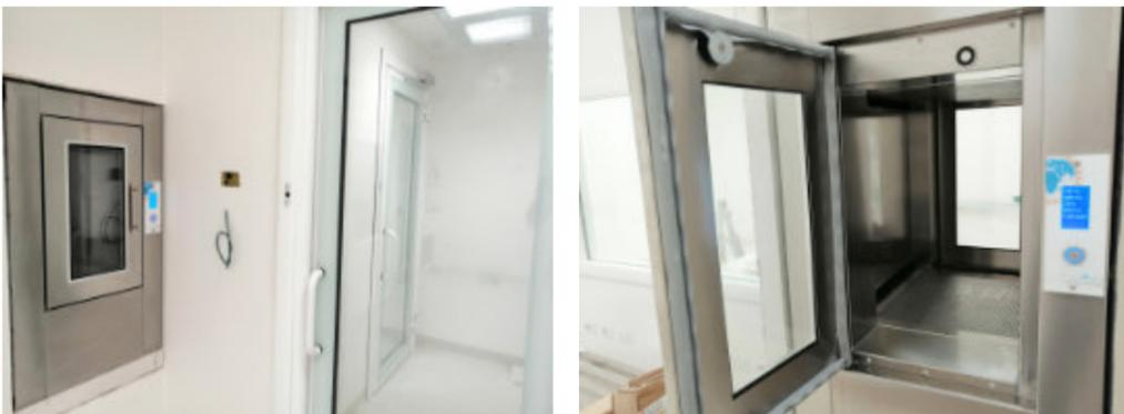
Passa malato automatica in acciaio inox con ante telescopiche in vetro temperato completo di porta battente manuale a tenuta per uscita di emergenza.
