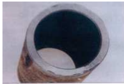
TUBO DI ACQUA POTABILE: PRIMA E DOPO LA PULITURA
