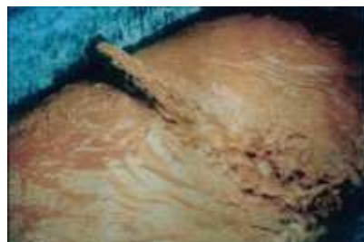
INCROSTAZIONI SCARICATE DURANTE LA PULITURA DA CONDOTTE DI ACQUA POTABILE
