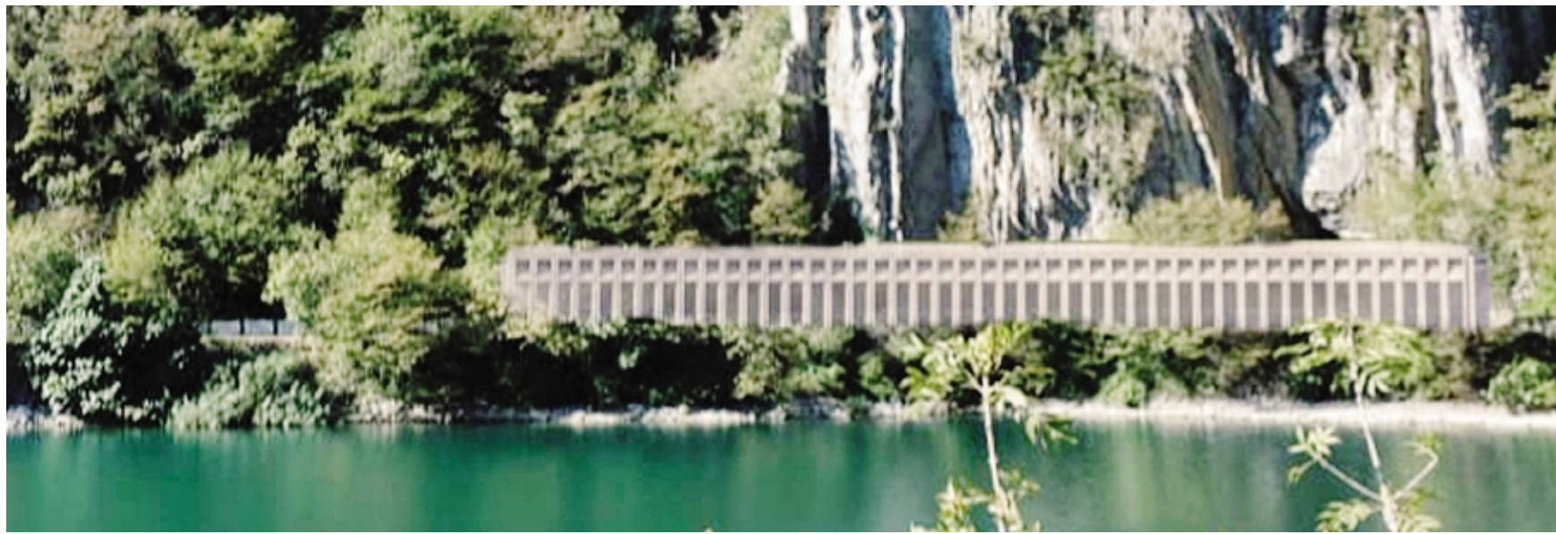
Il rendering della galleria artificiale para massi lunga 55 metri, prevista al Bögn
