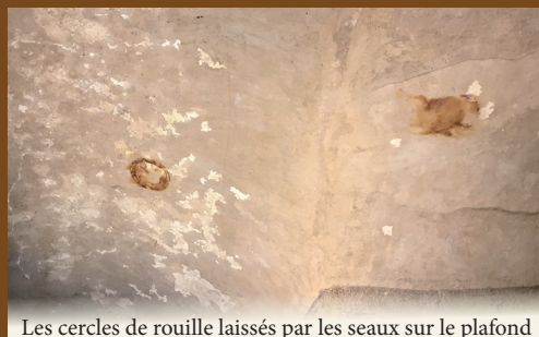
Les cercles de rouille laissés par les seaux sur le plafond
