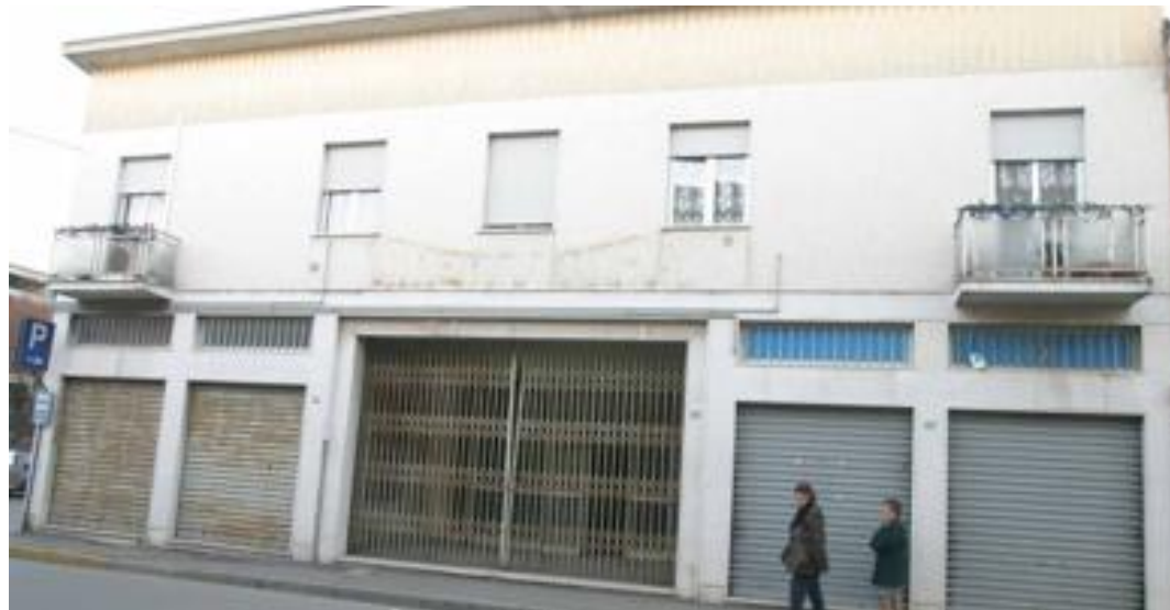
Si è già concluso il primo lotto dei lavori di riqualificazione dell'area dell'ex cinema Astra con la demolizione dello stabile
