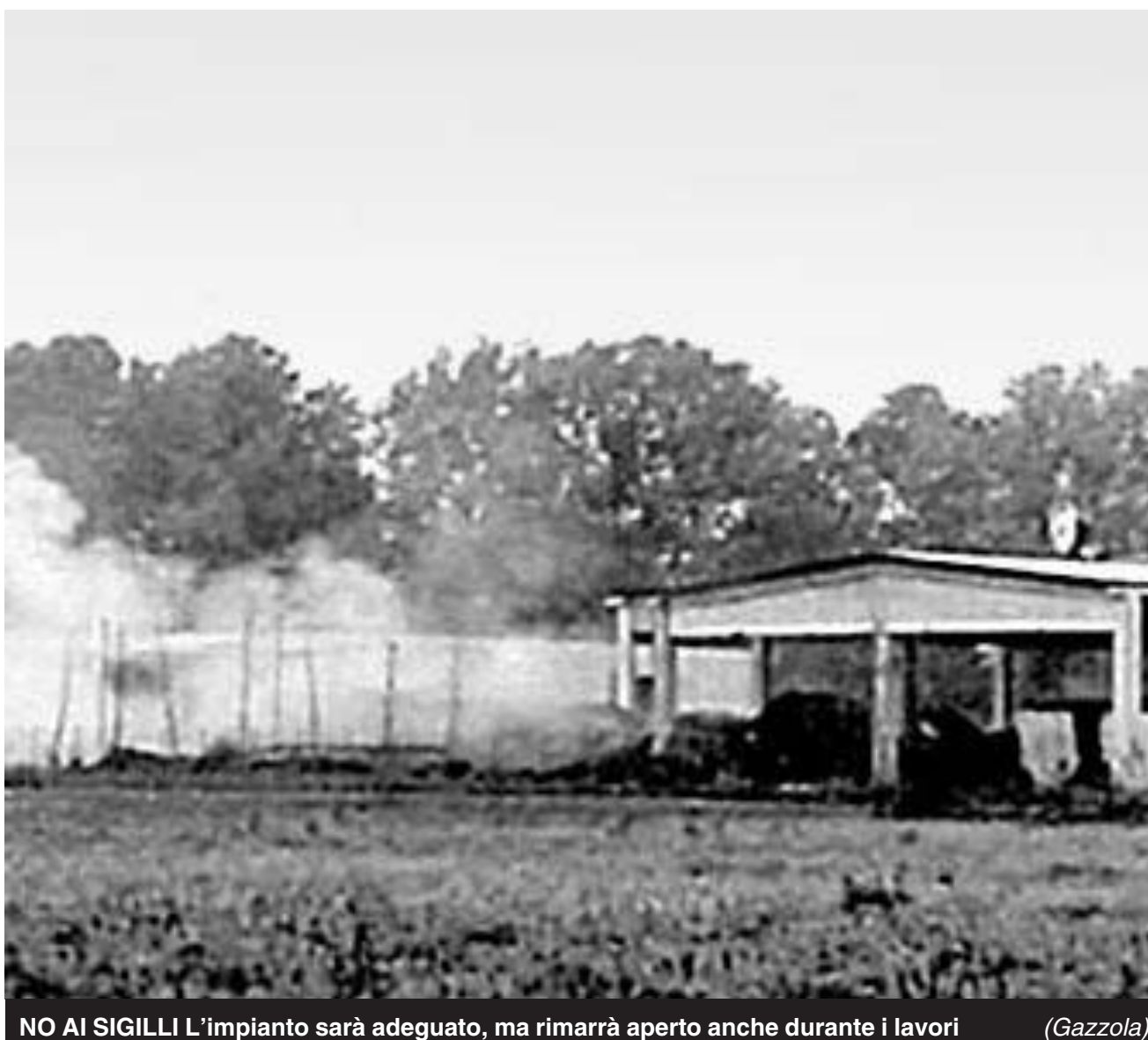
NO AI SIGILLI L'impianto sarà adeguato, ma rimarrà aperto anche durante i lavori
