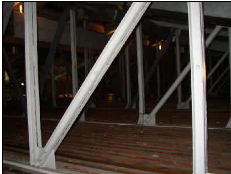
Capriate in acciaio del palcoscenico
