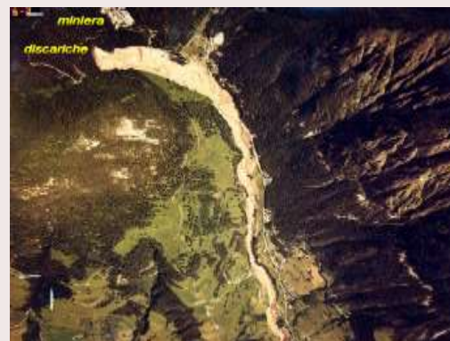
1985 Val di Stava Poco dopo il crollo
