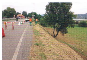
Stabilizzazione di una scarpata stradale con Chiodi Vegetali
